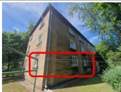
Dzīvojamā māja Stacijas ielā 117, dzīvokļa Nr.3 izvietojums tajā un logi
