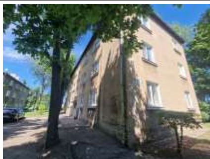
Dzīvojamā māja Stacijas ielā 117
